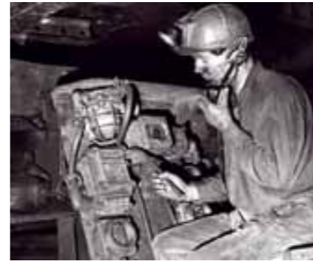
Hauer am Steuerstand um 1954. Hobelbegleiter leiteten ihn per Lichtsignal.
