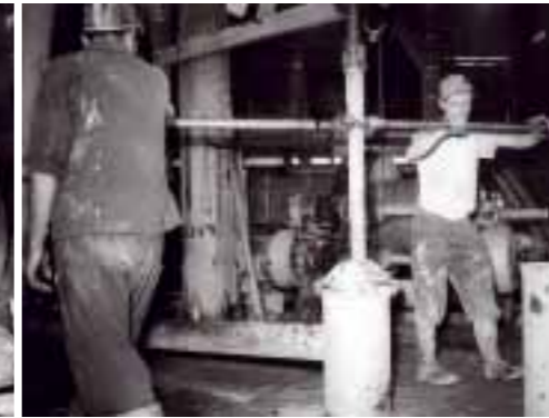
August 1955: Niederbringen der Bohrlöcher für den Frostkern im Schacht 1.
