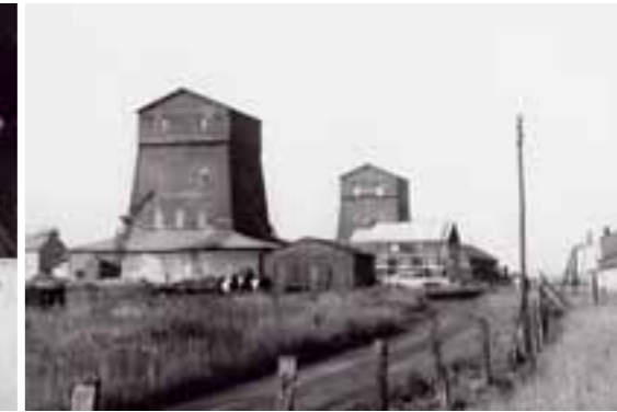
Abteuftürme der Schächte Rossenray Schacht 1 + 2 um 1962.
