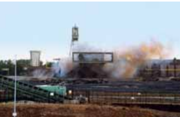
Sprengungsarbeiten zum Abbruch von Schacht 1 auf Pattberg im Jahr 1995.
